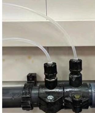
Si injections ou tuyaux bouchés les remplacer
