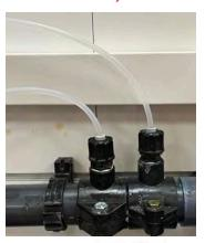
Si injections ou tuyaux bouchés les remplacer
